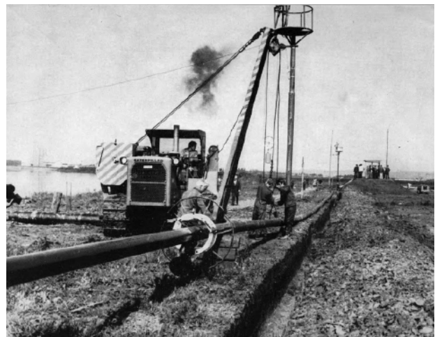
Slika 4. Gradnja naftovoda u slavonskoj ravnici
