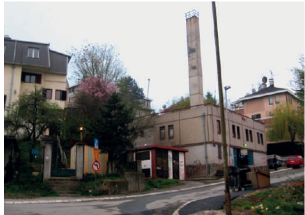
Kotlovnica i toplana Senjak, Beograd/ Srbija (izvor: Beogradske elektrane)
