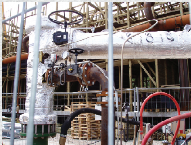
Slika 8. Ušće geotermalne bušotine u Njemačkoj-Unterhacking kod Minhena
